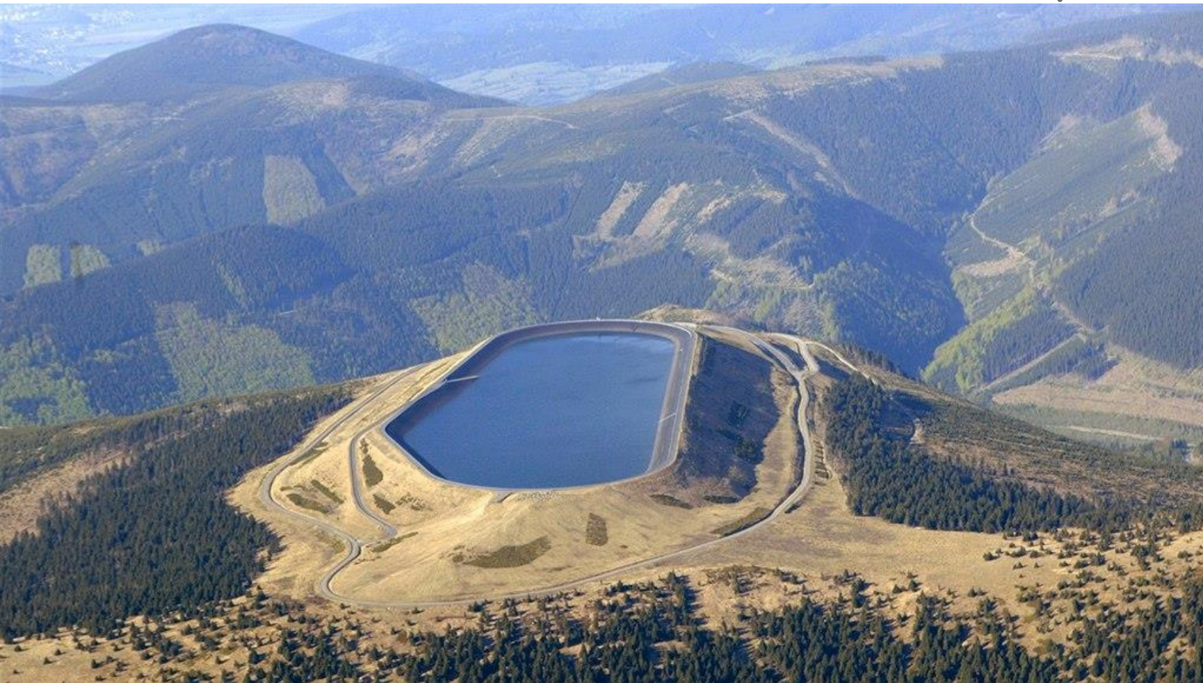
DLOUHÉ STRÁNĚ - PŘEČERPÁVACÍ VODNÍ ELEKTRÁRNA
